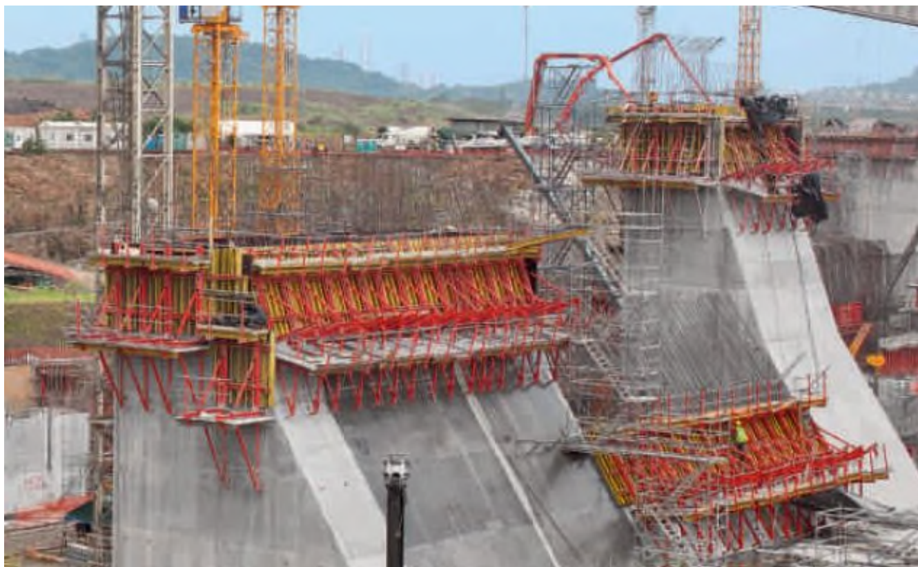
Figura 6 – Esempio di ponti di lavoro costituiti da mensole speciali da fissarsi alla struttura di sostegno dei casseri rampanti
