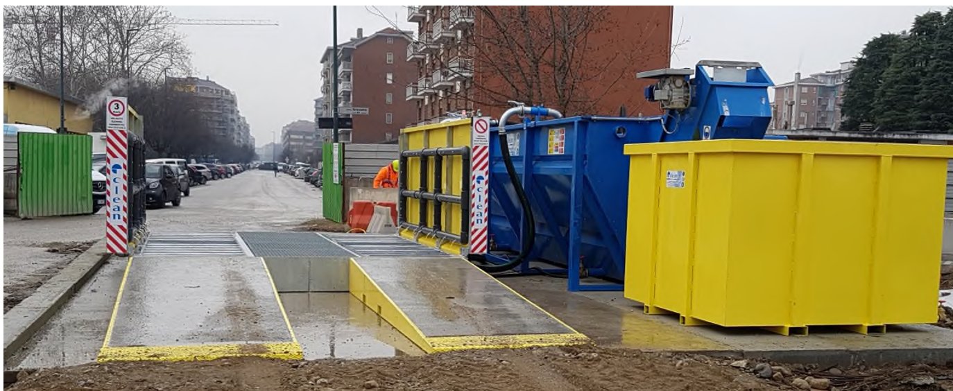
Figura 14 – Esempio di impianto lavar ruote da posizionare in corrispondenza degli ingressi alle piste di cantiere
